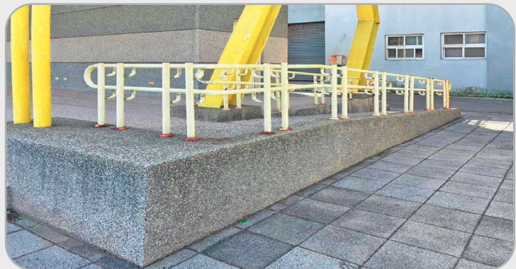
圖 C2_1_8_B 司令台 除了樓梯外，司令台增設符合規範的無障礙坡道。 資料來源：本研究 拍攝地點：和美實驗學校
