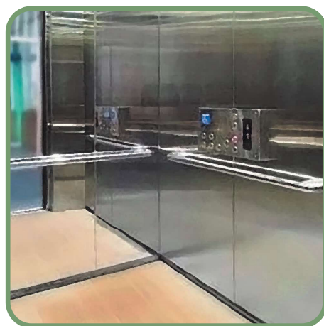
圖 406.2.3(補充_端部防勾撞設計)
